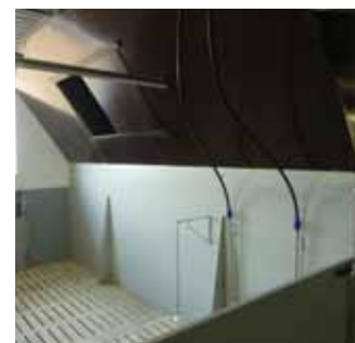
Ober- und Unterflurabsaugung
