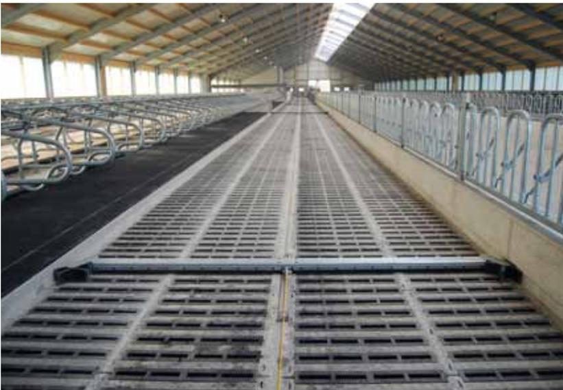
• Spaltenbodenschieber auf emissionsarmem Boden
