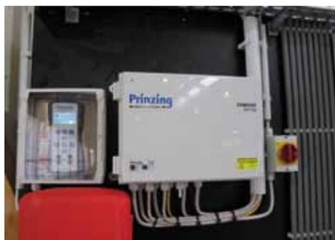
• Elektronischer Steuerungskasten, Typ Premium - ESC300 mit schnurloser Fernbedienung
