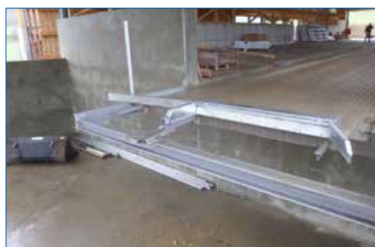
Abwurf Tretmist auf tieferliegende Mistplatte
