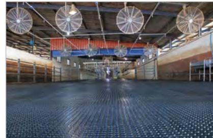
Die **EASYFIX MG Max 8** Gummimatte hat eine "Penny-Grip"- Oberfläche und bietet den Tieren eine Oberfläche auf der sie bequem und sicher laufen können. Der Polstereffekt der Matten verschafft mehr Kuhkomfort, dämmt Klauenprobleme ein und reduziert Lahmheiten.
